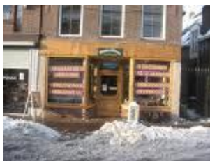
De verbouwing is begonnen
